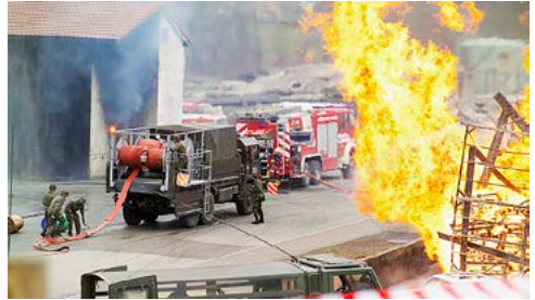
Assortiment de transport d'eau – pose d'une conduite de transport
